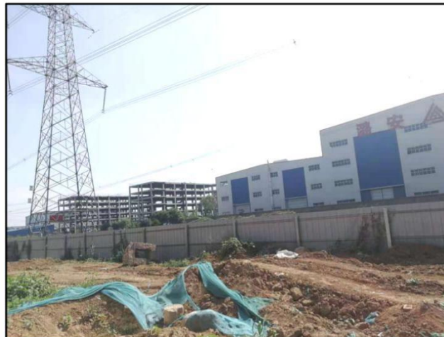
项目车间东侧
