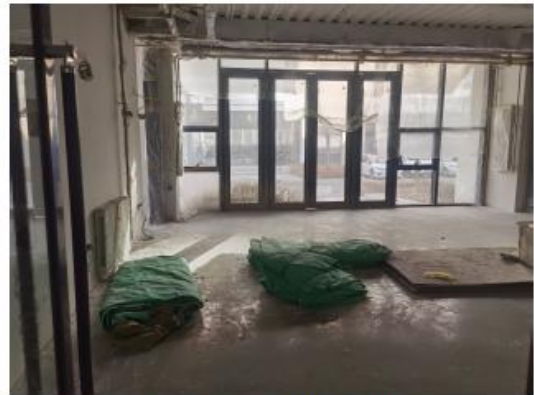
C34 栋 1 层（铅房拟安装位置）
