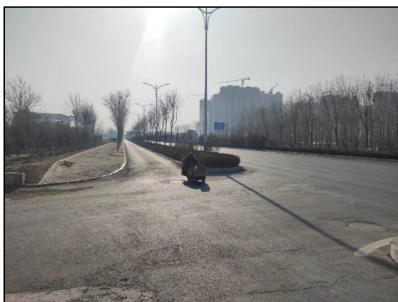
厂区西侧-环城西路
