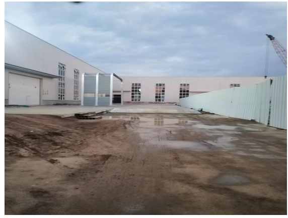
生产车间外部
