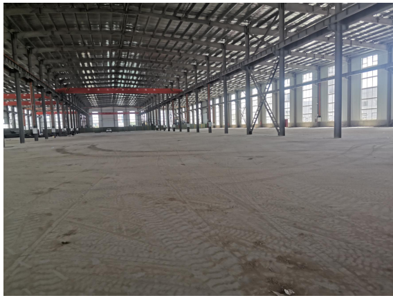
生产车间内部
