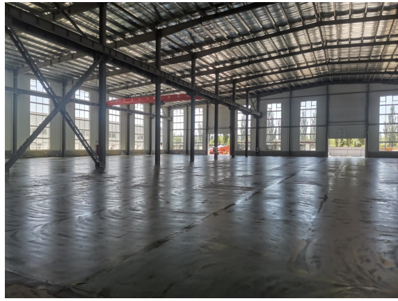
生产车间内部
