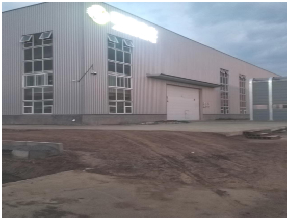
生产车间外部
