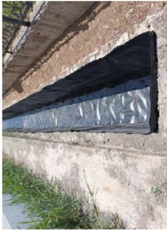
事故水池（施工期）
