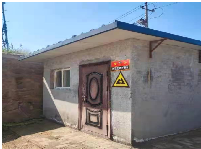
厂区危废暂存间
