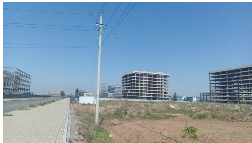
项目占地西侧
