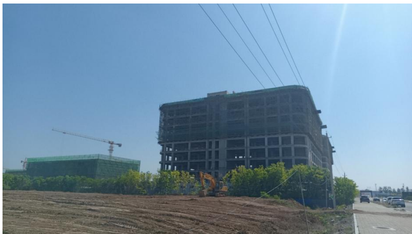
项目占地东侧
