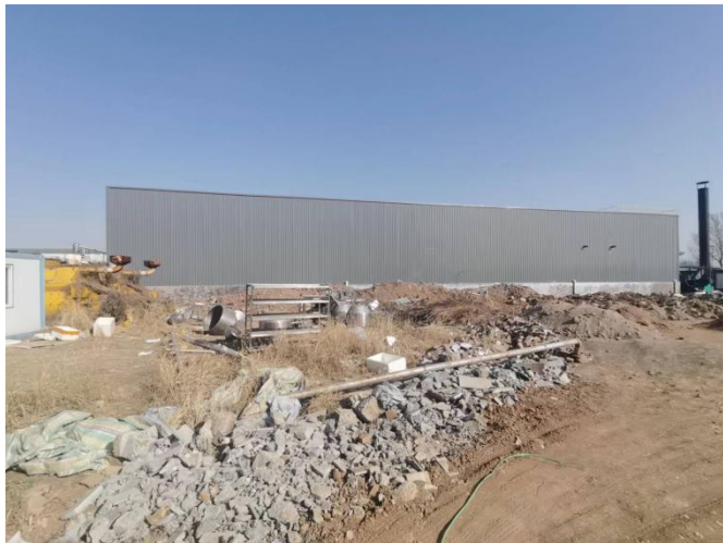
项目占地东侧（公司锅炉房）
