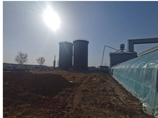
项目占地西侧
