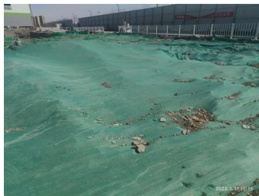
项目东侧（园区空地）
