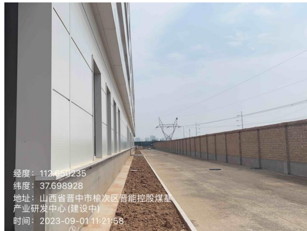
中试车间南侧
