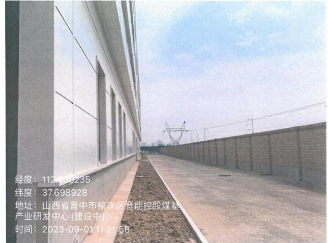
中试车间南侧
